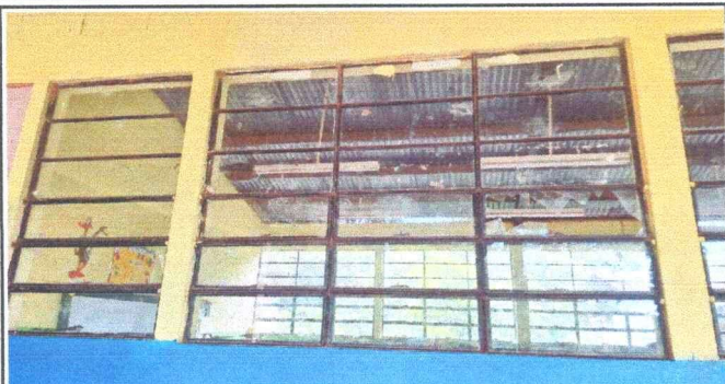
instalacion de balcones en el modulo 1, 2 y 3
