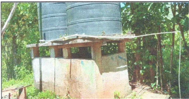
Foto 5: reparacion de tuberias y reposicion de tinaco
