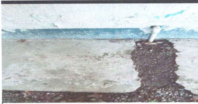
Sustitucion de piso por piso ceramico
